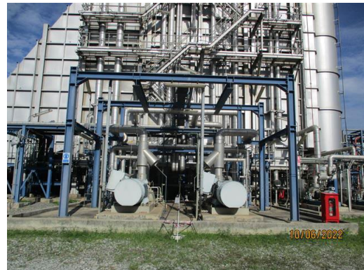
Boiler Feed Pump HRSG#11
