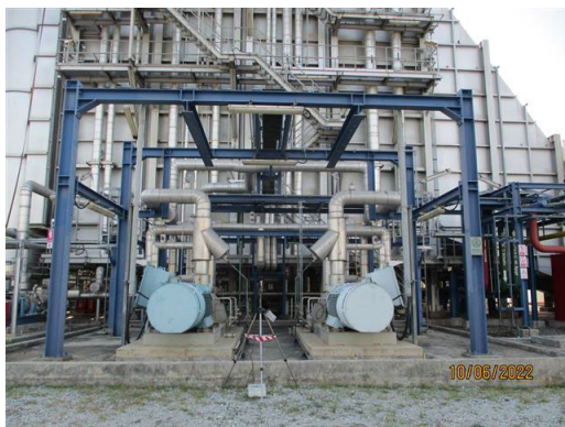
Boiler Feed Pump HRSG#12
